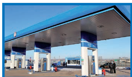
АВТОМОБИЛЬНАЯ ГАЗОНАПОЛНИТЕЛЬНАЯ КОМПРЕССОРНАЯ СТАНЦИЯ (АГНКС)
